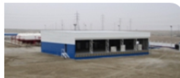
Instalaciones Planta Mejillones.
