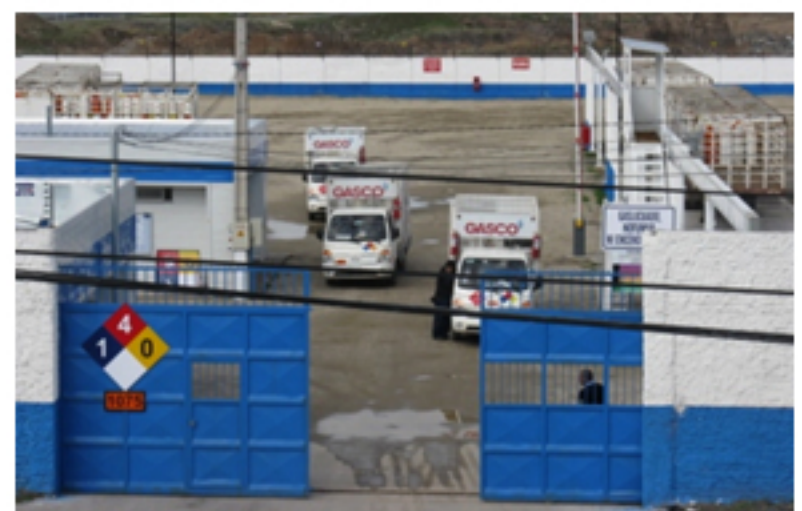
Instalaciones del nuevo CD Puente Alto.
